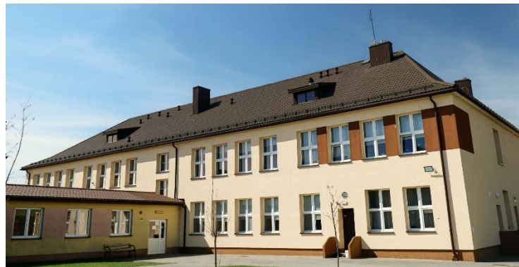
Wyremontowany dach budynku ZPO w Gąsiewie Poduchownym
