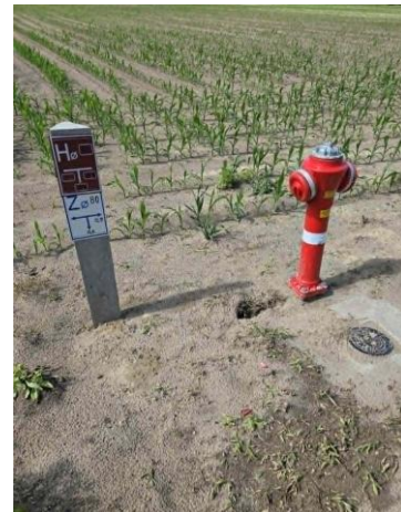
Wymiana zasów i hydrantów na sieci
