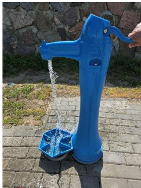
Nowe źródło wody przy cmentarzu parafialnym w Sypniewie
