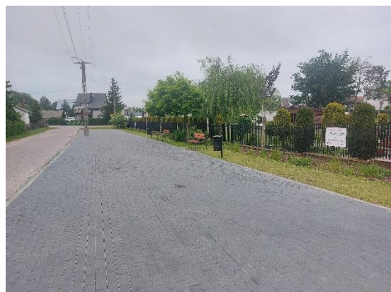
Realizacja budowy placu wiejskiego w Sypniewie z udziałem środków „Mazowsze dla sołectw”
