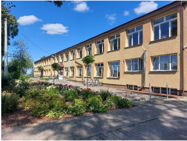
Dalsza część remontu budynku ZPO w Sypniewie i nowe nasadzenia zieleni
